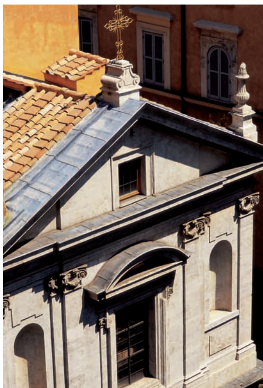
La façade principale de l'église Saint-Nicolas-des-Lorrains. (Photo Jean Luc Tartarin).
